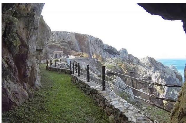
Tratto del sentiero di Galleria Henry – Cala Domestica
