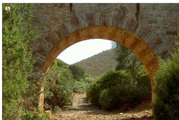
Ponte della ex ferrovia sul percorso Galleria Henry - Buggerru
