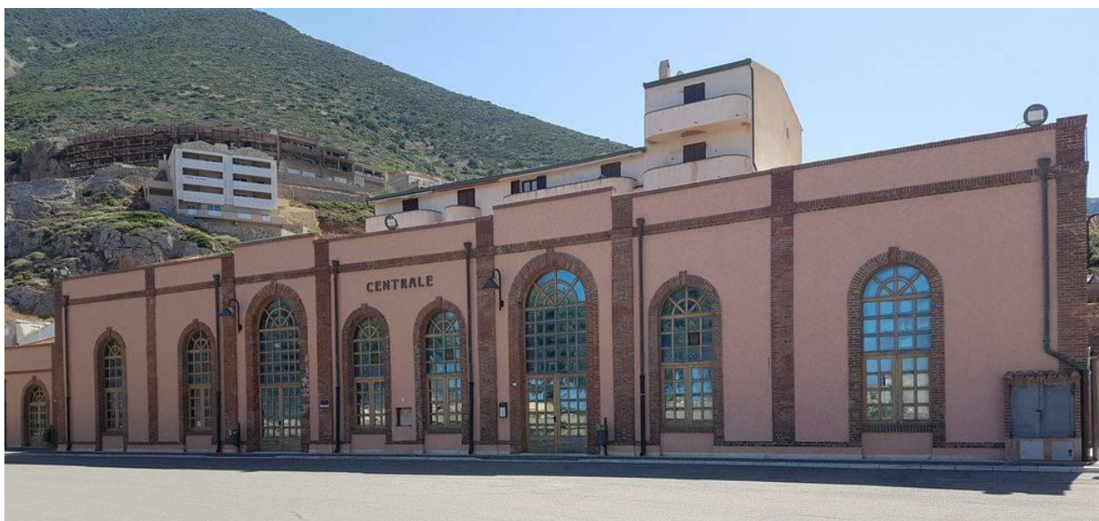
Ex Centrale elettrica
